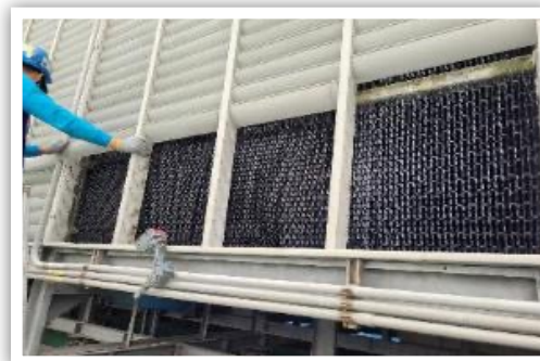
上圖：新豐廠冰機散熱片更換作業
