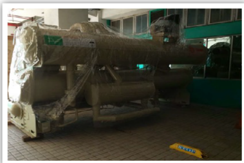
上圖：石磊廠 500RT 冰機汰換作業
